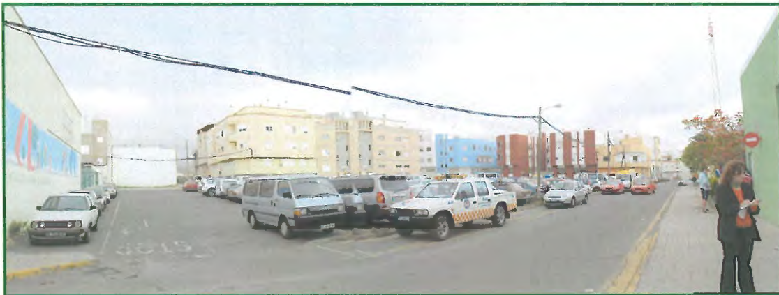
Imagen 6. Zona de aparcamientos junto al Colectivo "El Zaguán". Obsérvese el tendido eléctrico.
