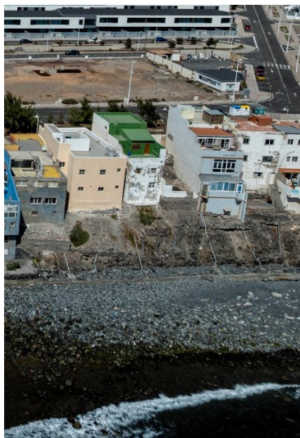
Imagen aérea de la costa de Pozo Izquierdo.
